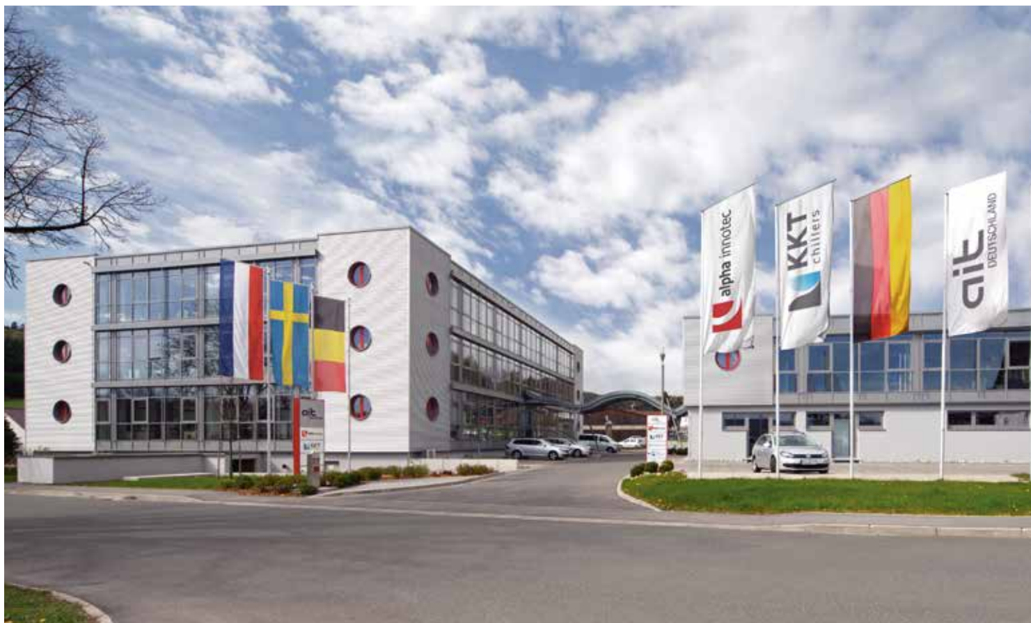
Zentrale alpha innotec in Kasendorf, Deutschland
