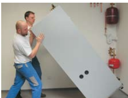
Die Wärmezentrale ankippen und richtig platzieren.
