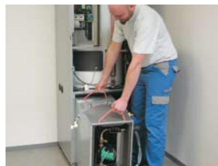
Kältebox in das Gerät schieben.
