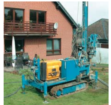
Bohrung für Erdwärmesonde
